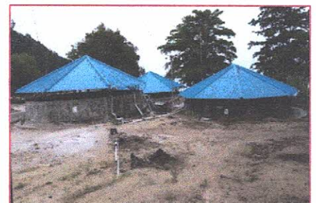
Bak Penampungan Air Laut
